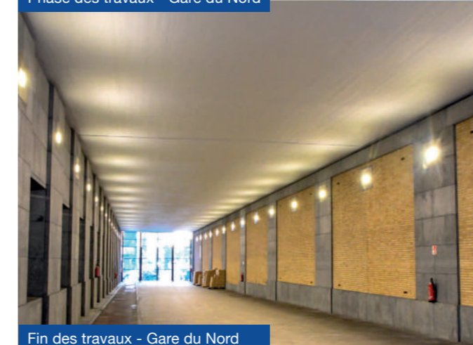
Fin des travaux - Gare du Nord
