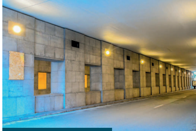
Einde van de werken - Noordstation
