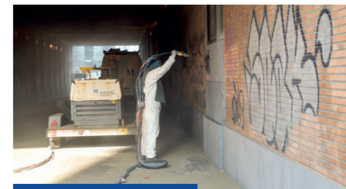
Phase des travaux - Gare du Nord
